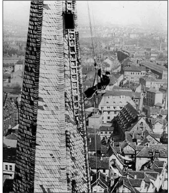
Traditionsunternehmen: Nach dem Zweiten Weltkrieg war die H. Rudolph Dacheindeckungen GmbH maßgeblich am Wiederaufbau Kassels mitbeteiligt. Unser Foto zeigt einen Mitarbeiter des Traditionsunternehmens am Turm der Martinskirche.
